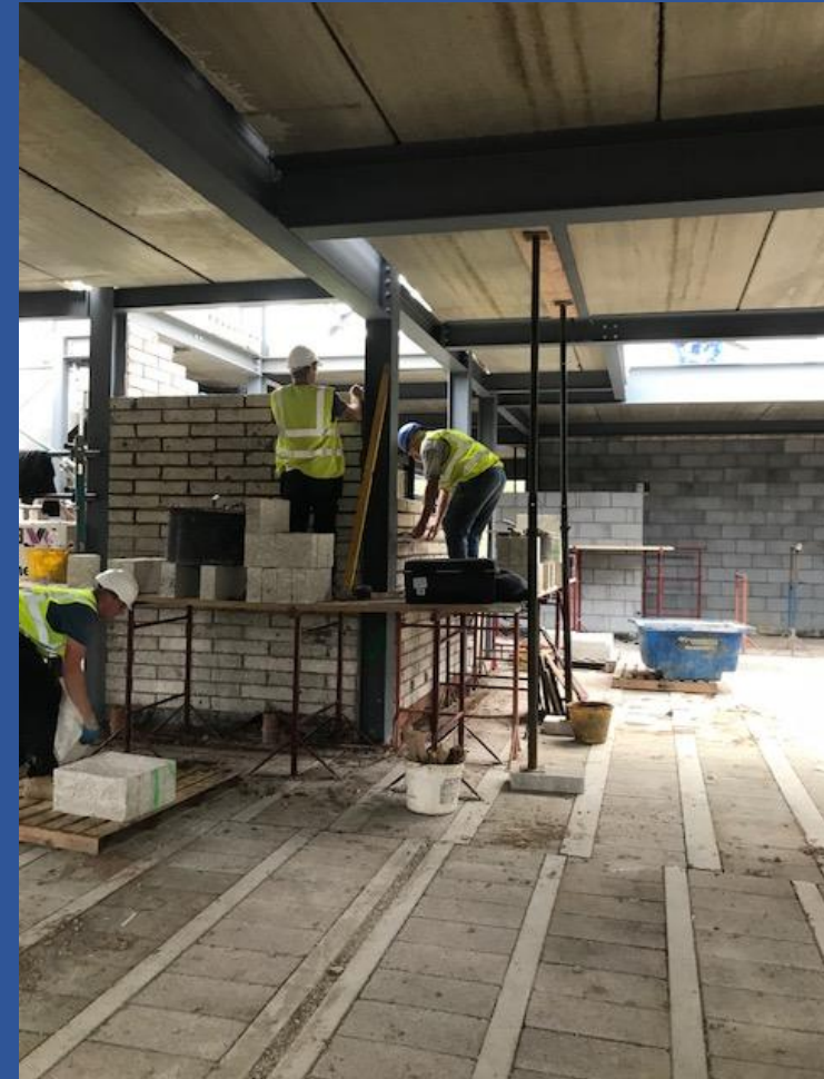
No edge protection ☹️
