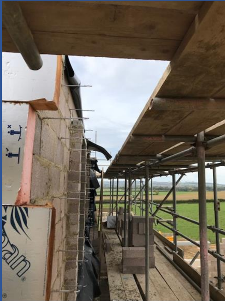
No internal edge protection ☹️
